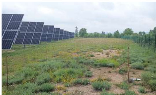
Modification du biotope de la Sabline des chaumes après installation et gestion d'un parc photovoltaïque. © J. G.
