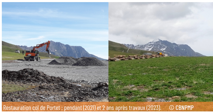
Restauration col de Portet : pendant (2021) et 2 ans après travaux (2023). © CBNPMP
